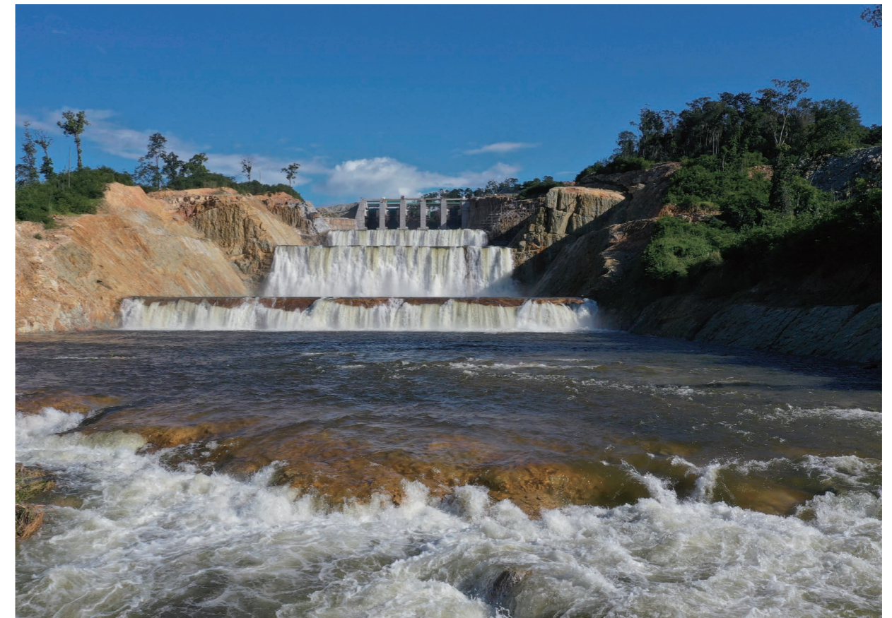
▲ 老挝南公 1 水电站三级消力池
