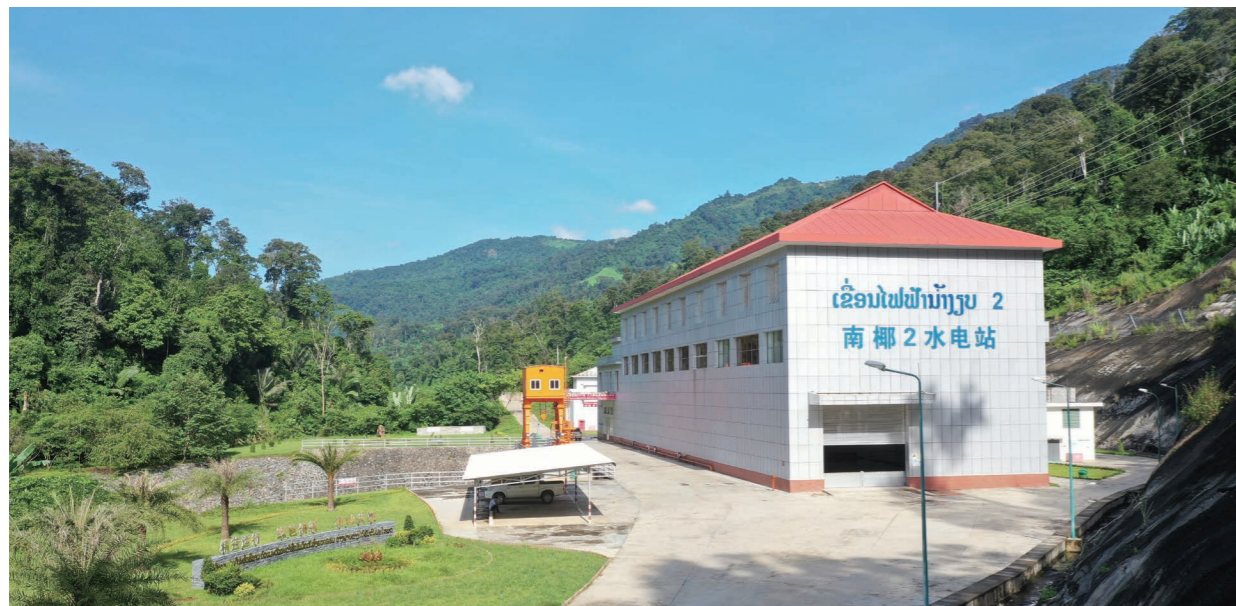
▲ 老挝南椰 2 水电站发电厂房
